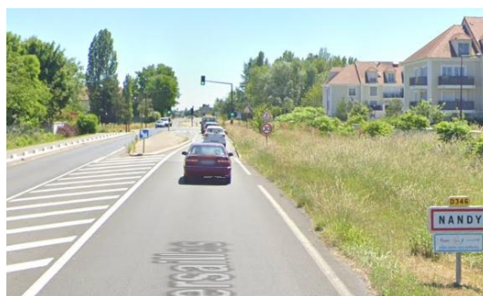
Entrée de ville RD 346 Ouest
