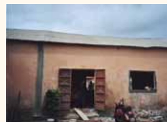
Bibliothèque avant travaux
