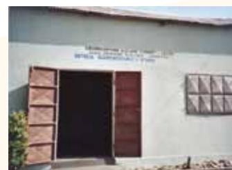
Bibliothèque après travaux
